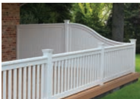
Sichtschutzwand mit Terrassengeländer.
